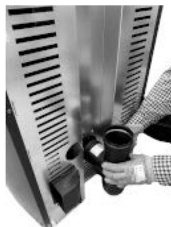
*Fig. 58 - Conecte el racor en T*
