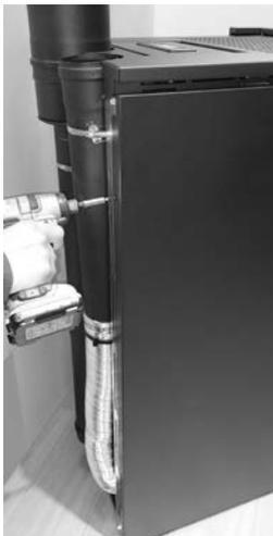
**Fig. 23 - Extracción de los tornillos traseros**
