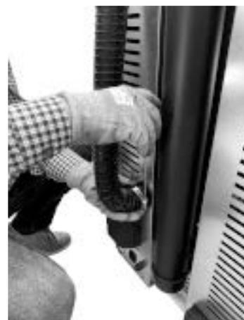
*Fig. 64 - Acople el tubo de aire comburente*
